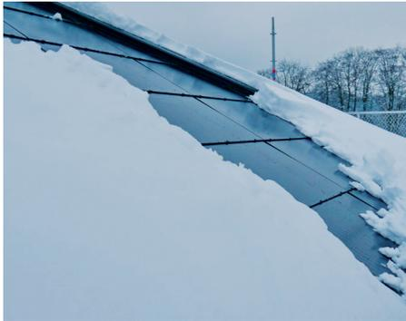
**Höhere Gewalt:** Durch Schneelast werden einige Module aus der Halterung gedrückt und erheblich beschädigt.
